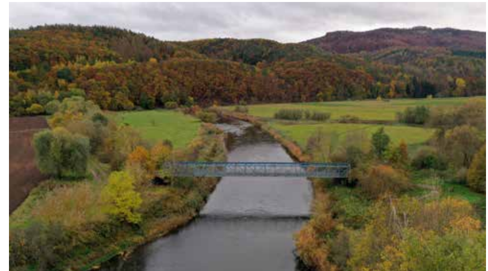
Ehemaliges Flussperrwerk der Werra (Grenzverlauf zu DDR-Zeiten in der Flussmitte)
